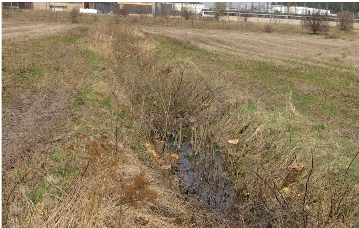
Fot. 1. Rów melioracyjny po przeprowadzeniu wycinki (fot z dnia 13.04.2010 r.)
